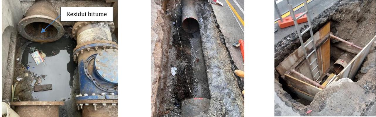
**Figura 9. Apertura dei punti di accesso/rimozione tronchetti (da sinistra verso destra punti A – A1 – B)**
