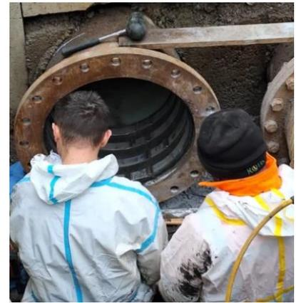
Figura 11. Monitoraggio dei parametri (sinistra) – installazione dei giunti di collegamento (destra)
