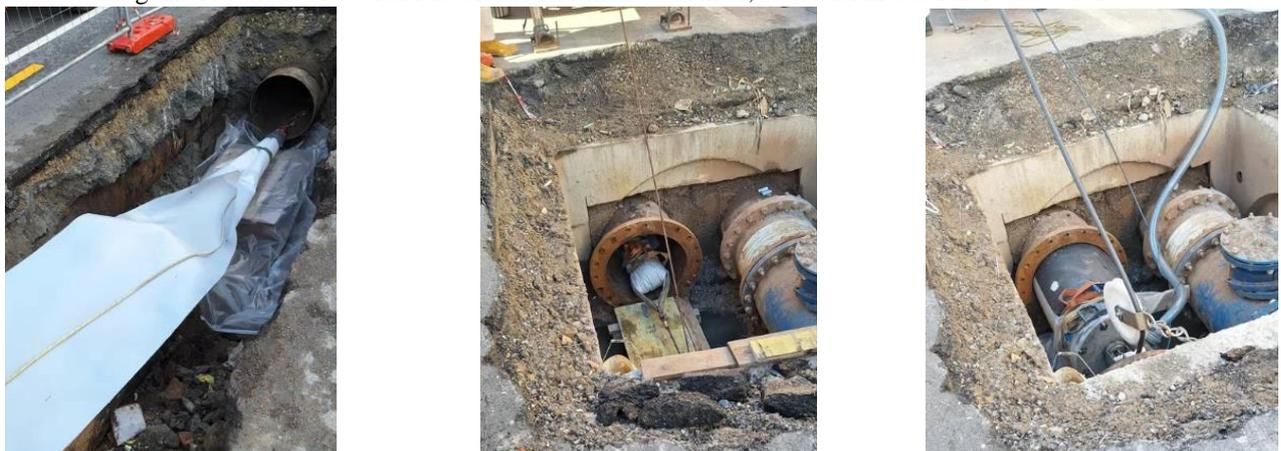
**Figura 10. Da sinistra verso destra: traino del liner nella condotta – uscita del liner nel pozzo di arrivo – gonfiaggio del liner**
