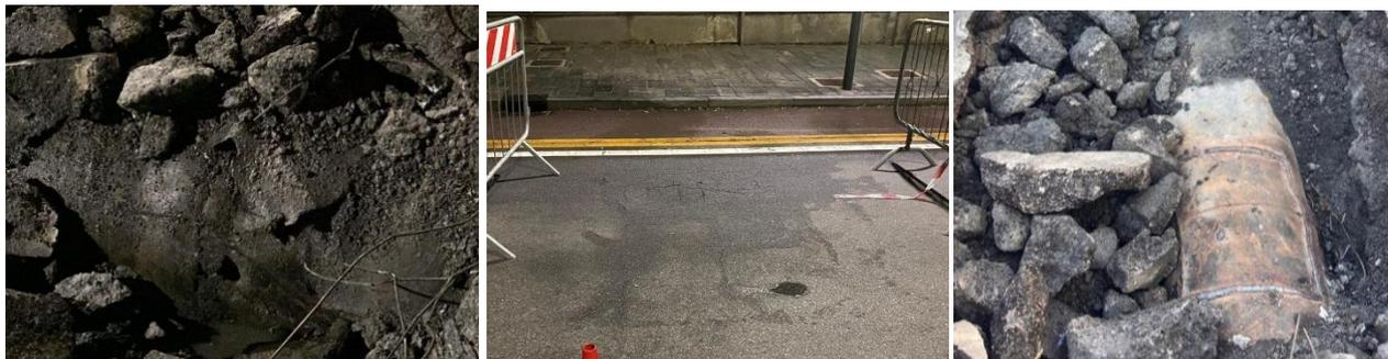
**Figura 3. Da sinistra verso destra: foro nella condotta – effetti della rottura sulla pavimentazione – intervento di ripristino**
